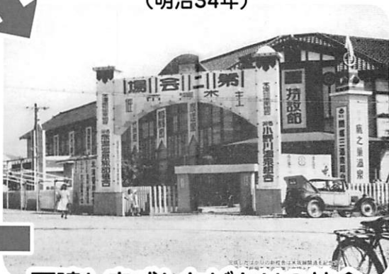
再建し完成したばかりの校舎 (昭和10年) 米坂線開通
